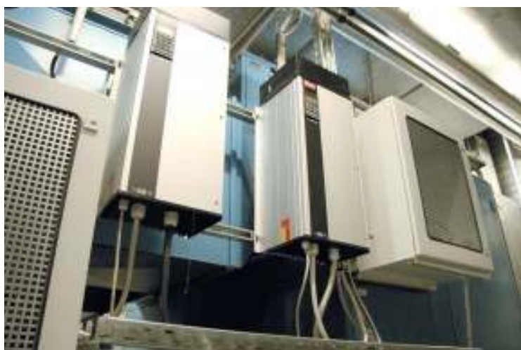
Einsatz von Frequenzumformern für energieeffiziente Lüftungsanlagen
